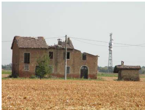
Figura 2: Edificio in ambito rurale (Foto A. Cattaneo)
