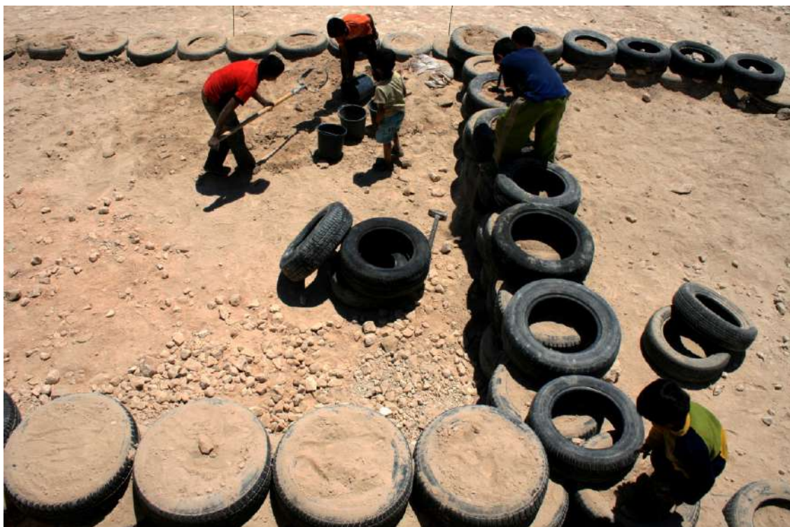
Figure 5: Al Khan Al Ahmar Primary School. La messa in opera dei copertoni, riempiti con pietre e terra cruda, è stata eseguita dalla gente del luogo che ha partecipato attivamente al processo di realizzazione. ©ARCò
