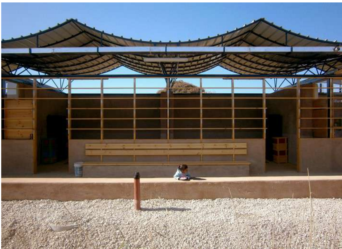
Figure 4: Children's Land_Um al Nasser. La scuola, una volta terminata, si presenta coerente con l'identità territoriale, grazie all'utilizzo dell'intonaco di argilla, i frangisole lignei e la copertura che richiama la forma della tenda del deserto. ©ARCò
