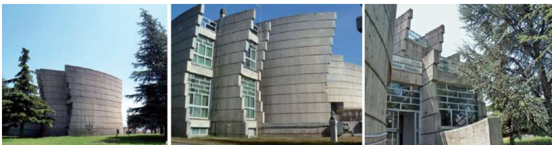
Figura 4: Centro promozione culturale "I. Silone" Avezzano (AQ)
