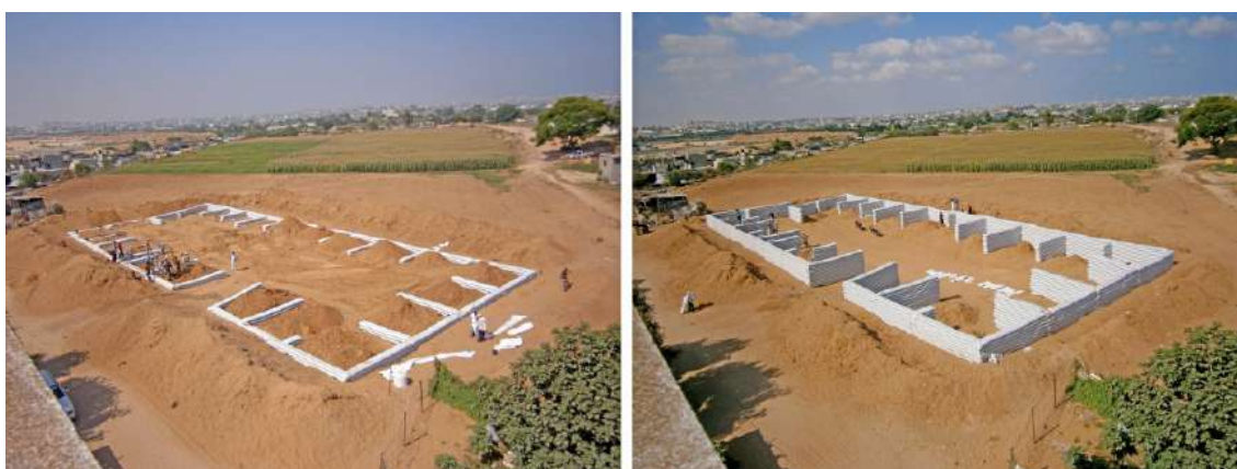
Figure 2: Children's Land_Um al Nasser. Fasi di costruzione della muratura con sacchi e terra cruda. ©ARCÒ
