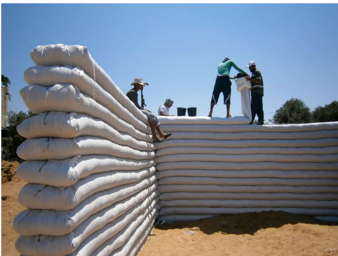
Figure 3: Children's Land_Um al Nasser. La realizzazione è stata possibile grazie alla partecipazione della gente del luogo, manodopera non specializzata ma facilmente coinvolgibile nel processo costruttivo. ©ARCò
